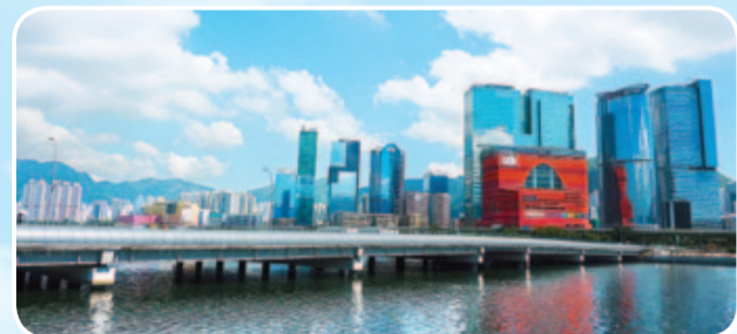
啟德橋 Kai Tak Bridge
